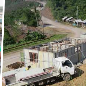
Baustart von sturmsicheren Häusern
