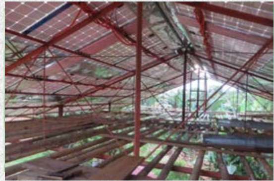
Die neue Solaranlage in SAFRA-ADAP liefert 16 kW Strom
